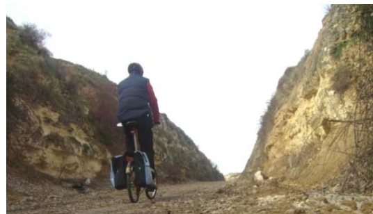
Salida de túnel de Perogordo y trinchera carbonática del Tejadilla a la salida del mismo.
