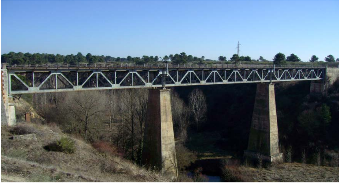
Puente de hierro sobre el río Voltoya, en el km 54.
